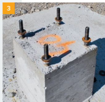
3 Снимите монтажную пластину PPL и выровняйте гайки.
