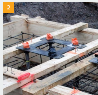
2 Установите монтажную пластину PPL с анкерными болтами на фундамент и залейте.
