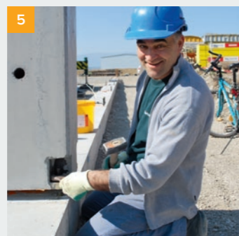
5 Затяните верхние гайки и проверьте вертикальность, отцепите кран.
